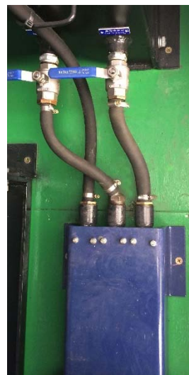
油箱进、回、排污 油管的地面保护
