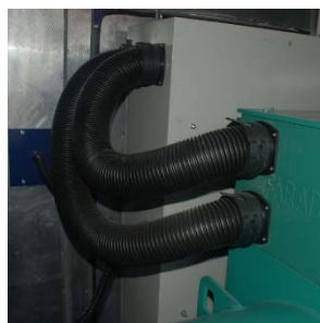
内部输出电缆走线
