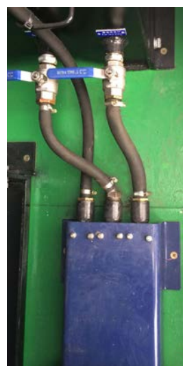
油箱进、回、排污 油管的的地面保护
