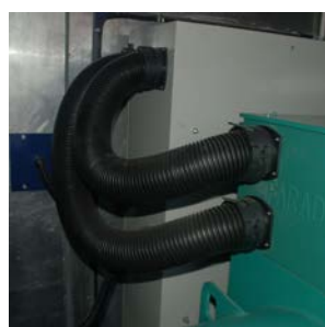
内部输出电缆走线
